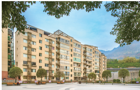
白杨坪片区党校居民楼老旧小区改造项目
