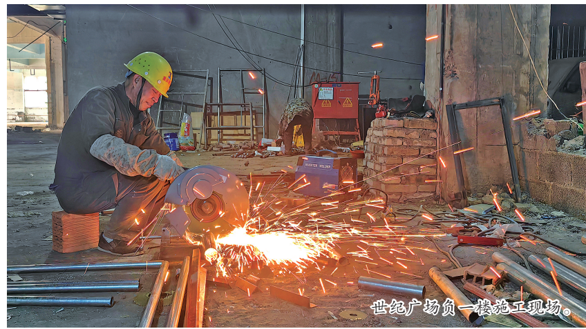
世纪广场负一楼施工现场。防照明及报警系统点位、36个钢制防火卷帘门及850平方米周边墙体的安装建设工作，施工进度已完成80%。人民广场隐患整治施工面积共计29280平方米，现已完成500平方米的暖通，6750米的喷淋主管和1266个消防照明及报警系统点位安装，已完
