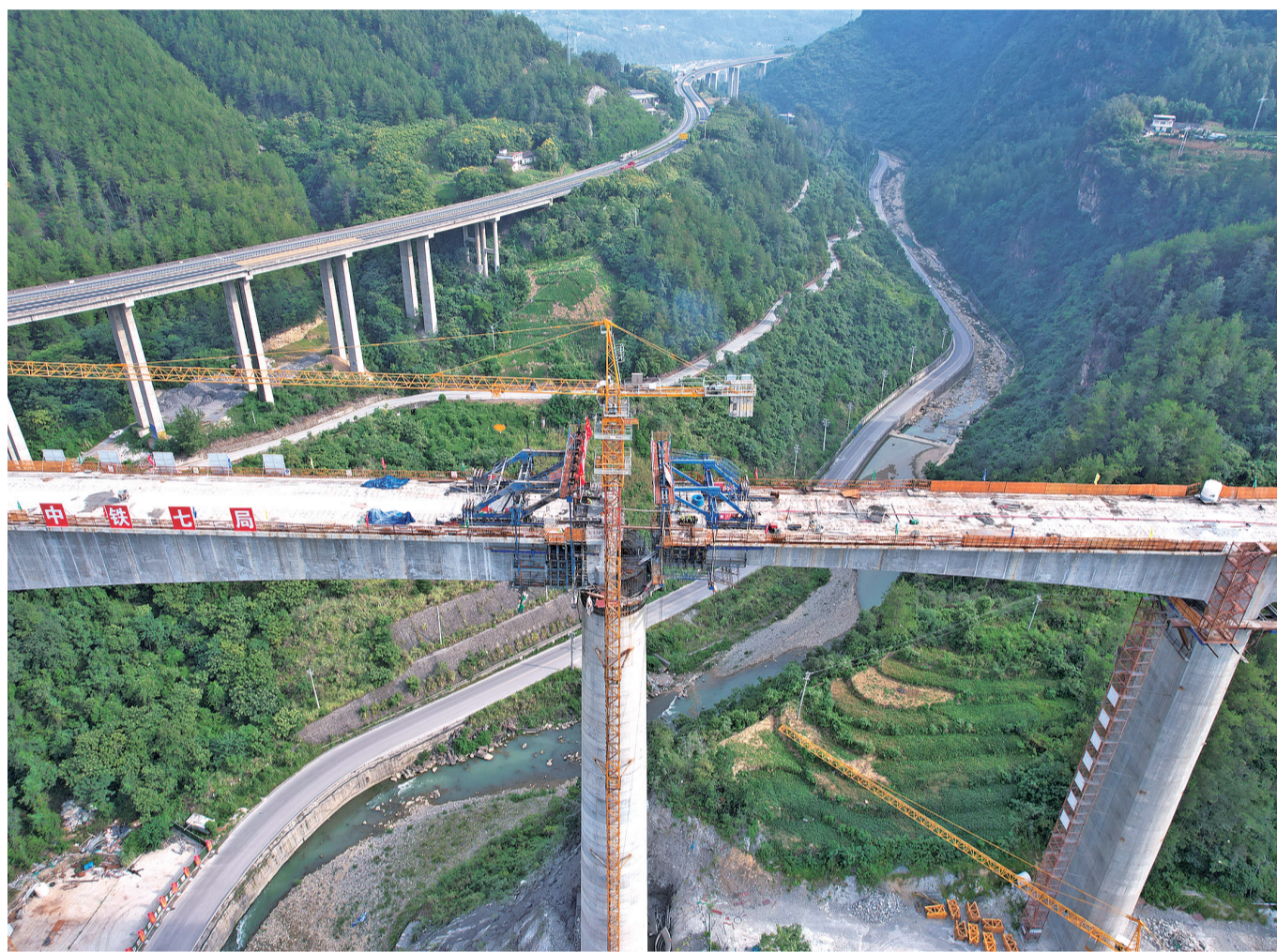
渝湘高铁石梁河双线特大桥顺利合龙。(廖星晨/摄)
