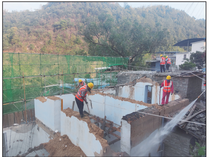
D级危房拆除。(阳 凤/摄)
