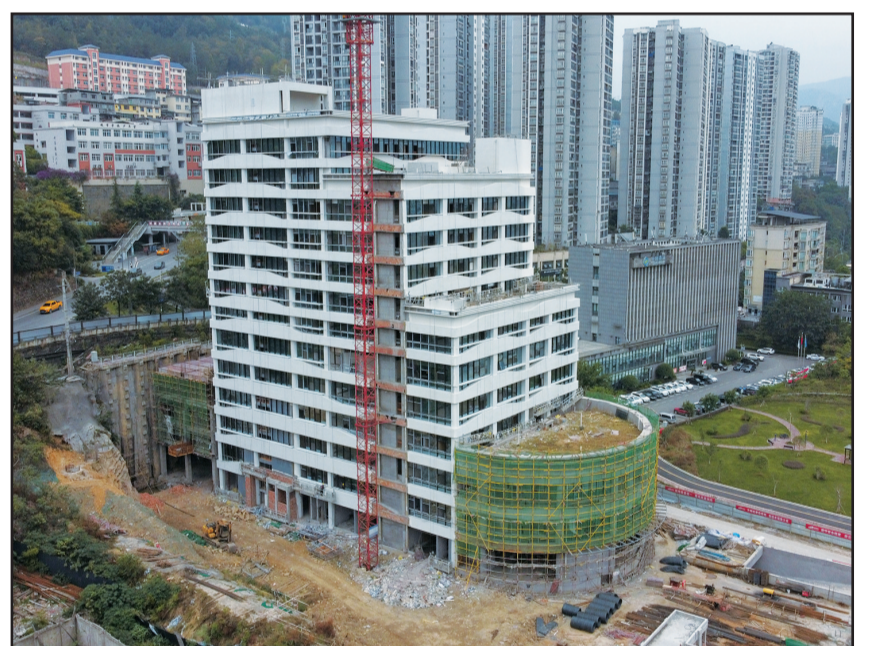
建设中的区妇幼保健院儿科大楼。(代君君/摄)
