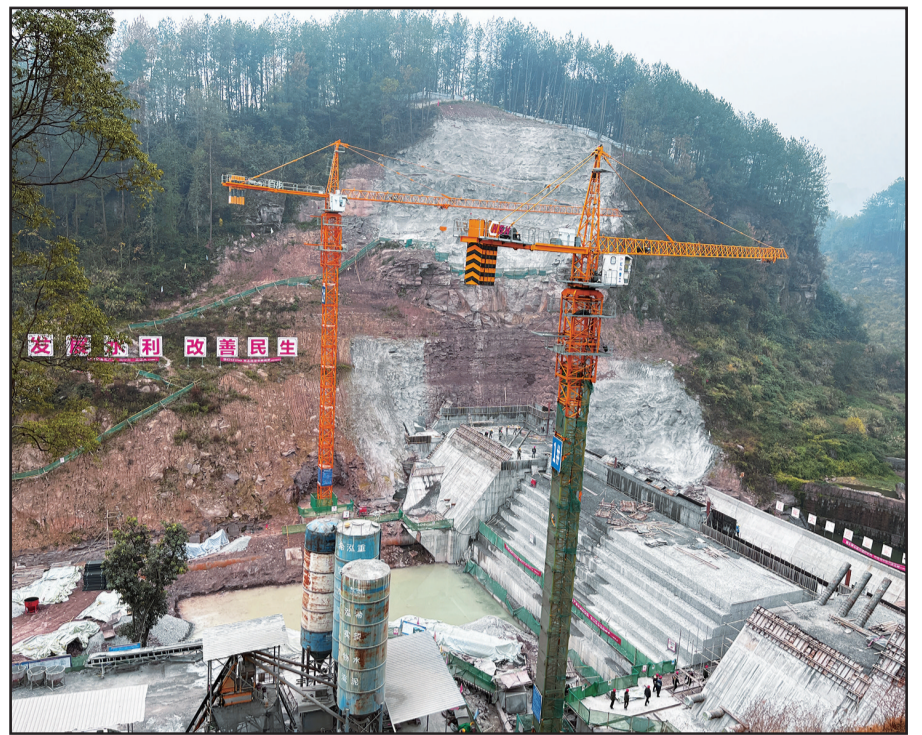
姜家溪水库建设。(王 颖/摄)
