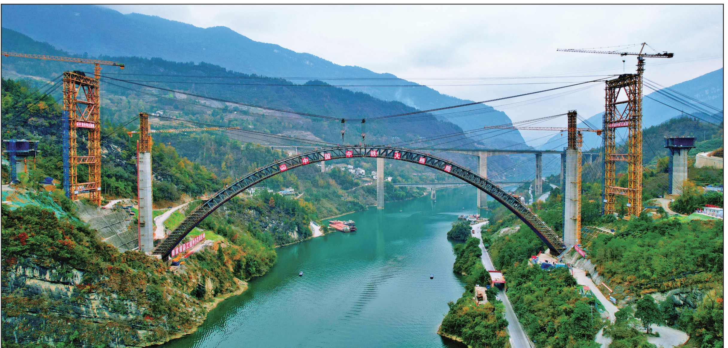
渝湘高铁黄草乌江双线大桥主拱合龙。(罗雪琴/摄)
