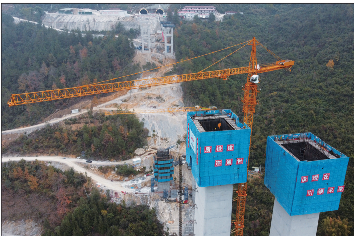
巴彭路13标项目黄草乌江特大桥27号主墩顺利封顶。(代君君/摄)
